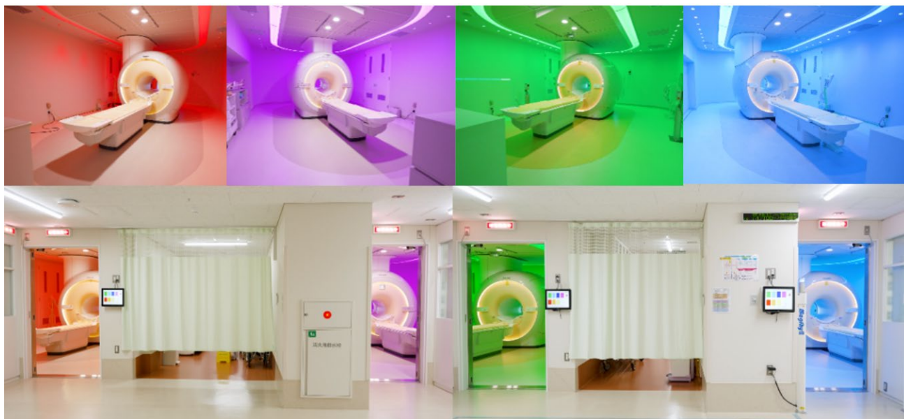
図2 一直線に配置された4部屋のMRI検査室
